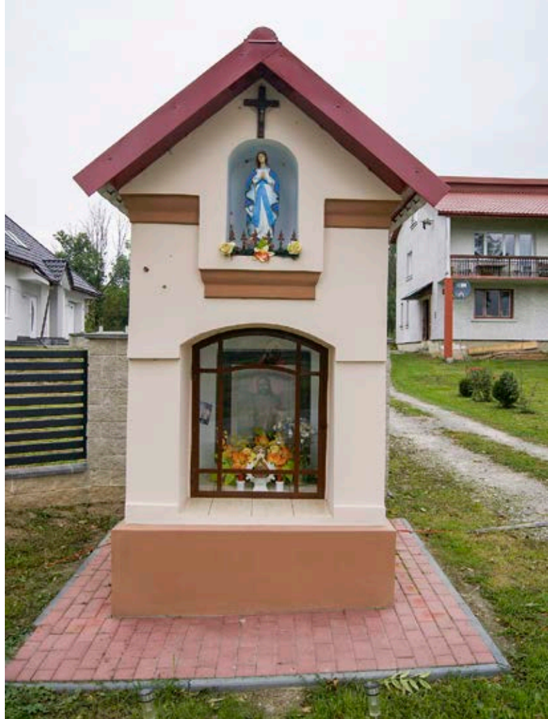
Kapliczka przy drodze gminnej z końca XIX w. w Ruszelczycach Chapel by the municipal road in Ruszelczyce from the end of the 19th century
